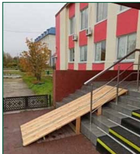
Здание МБУ ДО «Детская школа искусств», г. Югорск
